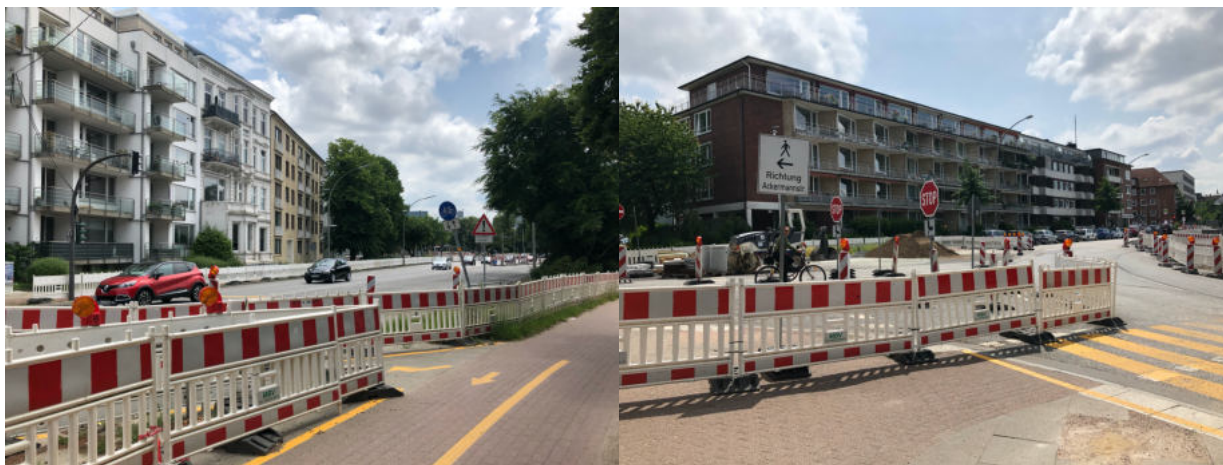
BAUSTELLE VOM SCHWANKENWIK AUS (L.), BAUSTELLE BARCASTRASSE/GRAUMANNSWEG (R.)
