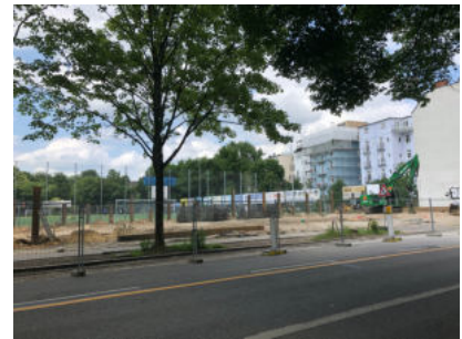
BAUSTELLE AM SV UHLENHORST-ADLER
